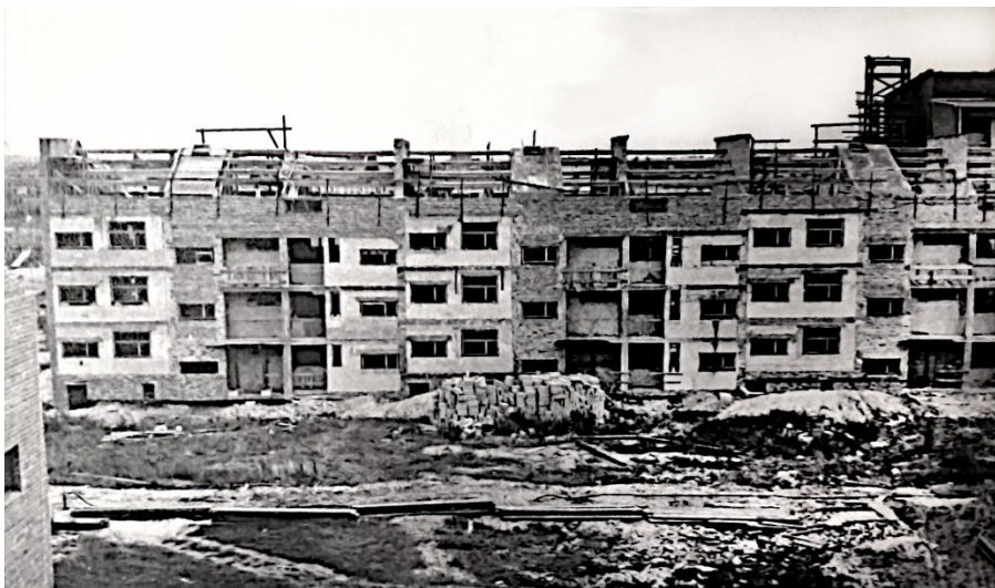
Budowa bloku przy ul. Garwolińskiej 26. Rok 1959. Fotografia z archiwum Osiedla Szaserów.
